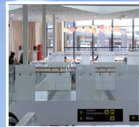
MODERNT RESECENTRUM Uppsalas nya resecentrum med biljetthall, väntrum och butiker är nu invigt. Alviks Måleri hade målerientreprenaden. Skanska var beställare.
