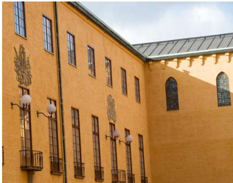
PÅ HISTORISKA MUSEET HAR ETT HUNDRATAL FÖNSTER OCH FÖNSTERDÖRRAR BLIVIT RENOVERADE.
