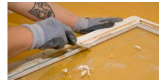
2. FÖNSTERNAS RENOVERAS STEG FÖR STEG. KITTET TAS BORT.
