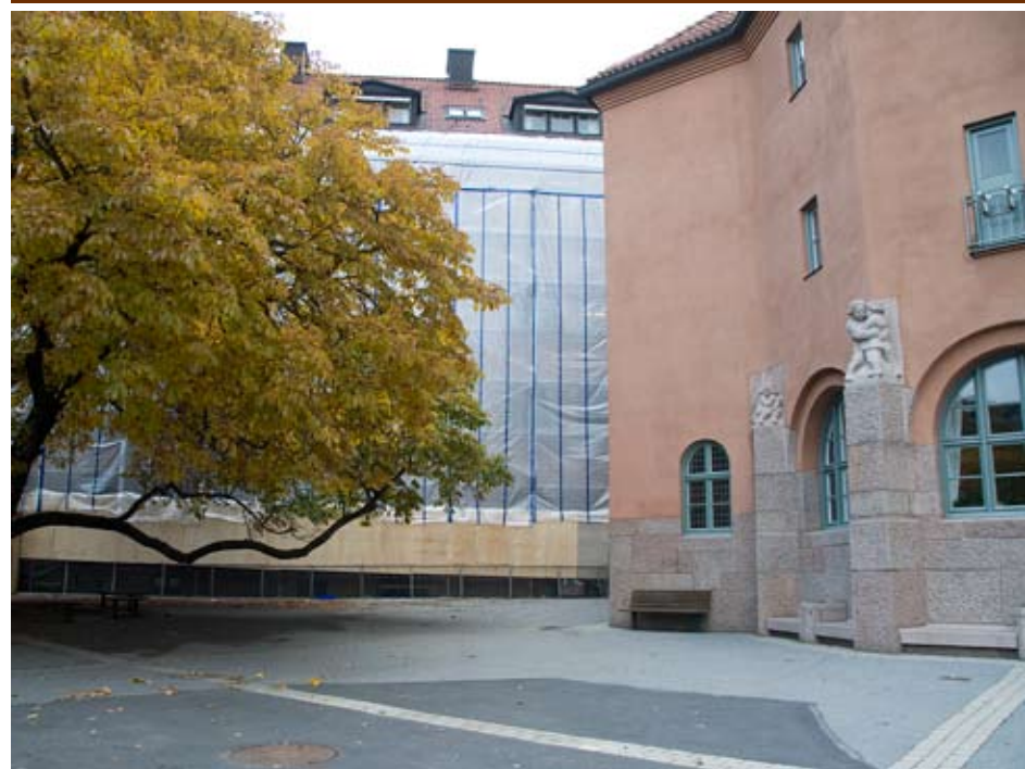
HÄR HAR FÖNSTER PLOCKATS NER FÖR ATT MÅLAS OM I VERKSTAD. FÖNSTERSKYDDEN I KANALPLAST HAR LJUSINSLÄPP OCH EN VÄRMEISOLERANDE EFFEKT.
