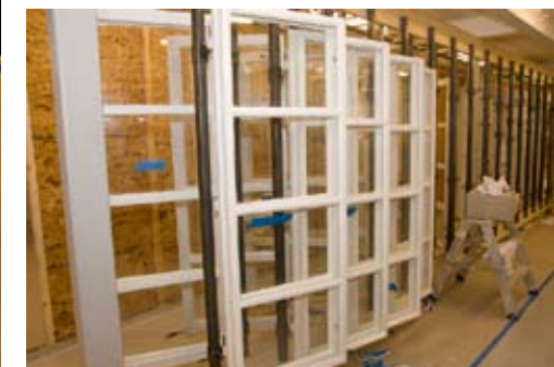
6... OCH SLUTLIGEN HÄNGS FÖNSTERBÅGARNAS UPP FÖR MÅLNING.
