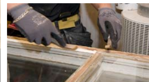
5. NYTT GLAS OCH KITT SÄTTS I DÄR DET BEHÖVS...
