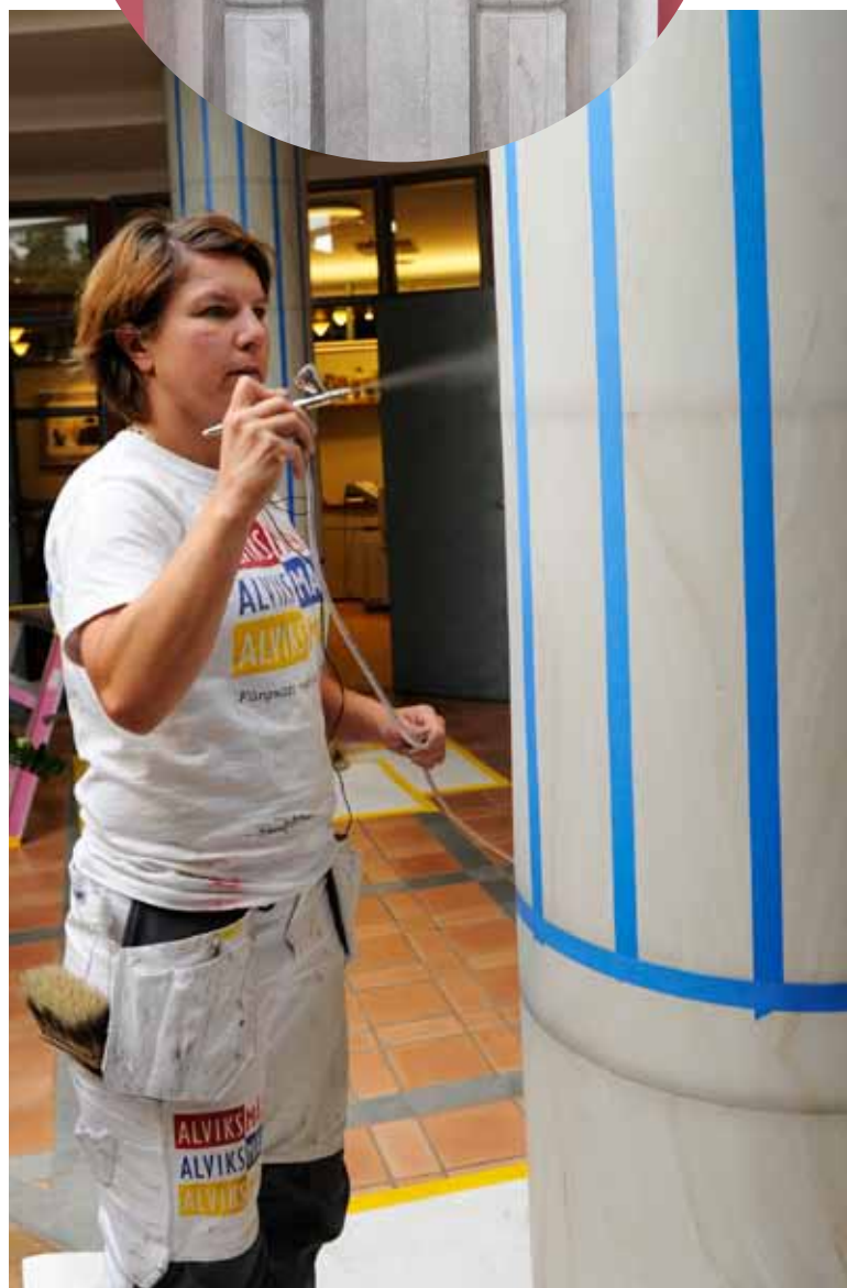
PELARNÄ PÅ ALVIKS MÅLERIS KONTOR I BROMMA SER NU UT SOM MARMORPELARE FRÅN ANTIKEN. ANNA-KARIN, DEKORATIONSMÅLARE PROVAR ATT SPRUTMÅLA FÖR ATT FÅ SKUGGOR SOM ÄR RIKTIGT VERKLIGHETSTROGNA. FÖRLAGAN ÄR ETT FOTO.
