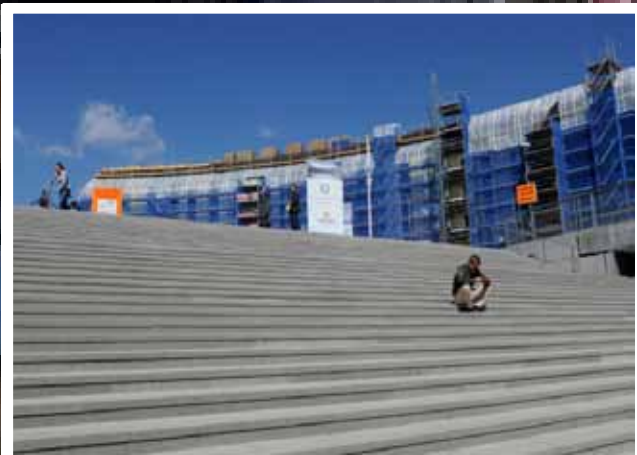
RADISSON BLU byggs bakom centralstationen. Ett helt nytt hotell med 185 rum, plus konferensdel och restaurang. Winn Hotel kommer att stå för driften av hotellet. Skanska är byggtreprenör.
