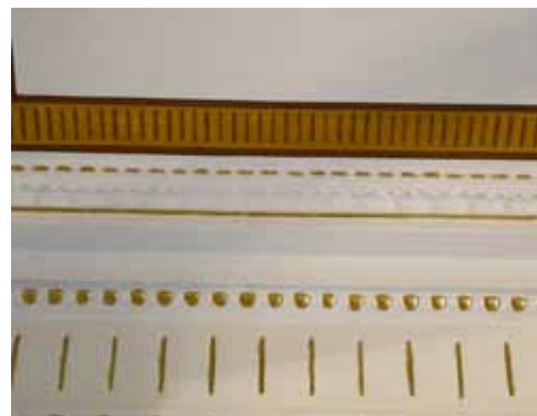
DETALJ AV BÅRD I TAKET.
